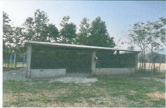
Foto 2: Mejoramiento con instalación de puertas, ventanas y balcones. ✓
