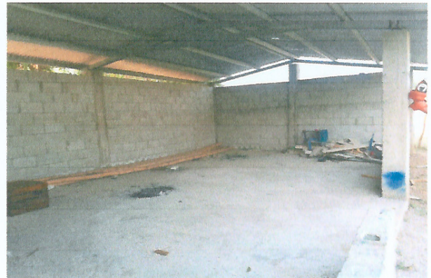
Foto 4: Mejoramiento de losa de piso. ✓
