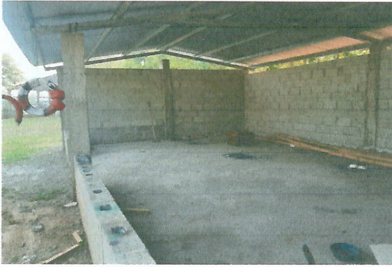
Foto 1: Mejoramiento con instalación de polletón y extractor de humo tipo campana. ✓
